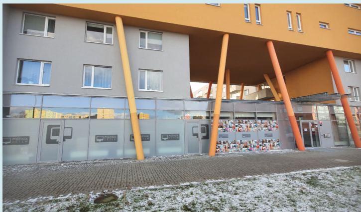
Instalační centrum na Opatově.
